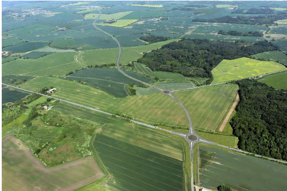
Figur 8 Visualisering set mod nordøst ved Vonsildvej af skitseprojektet for den nye vejforbindelse fra MKV'en af det samlede projekt fra 2019.
