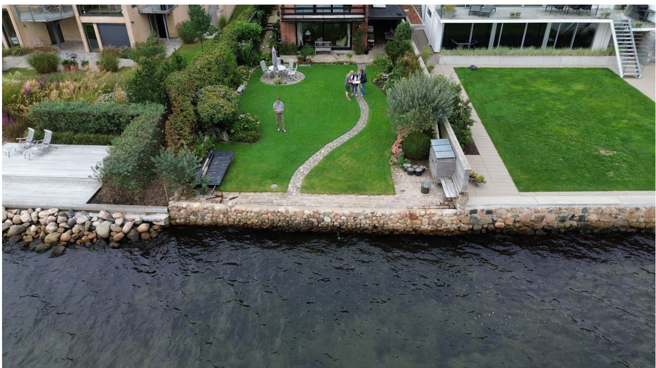
Foto 1.3– Eksisterende forhold (Fjordvej 106B ses i midten. Det ses at ejendommen mod vest nr. 106A har etableretstensætning.
