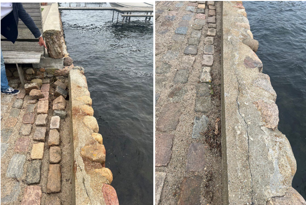
Fotos 1.1 & 1.2 – Eksisterende forhold betonmur.
