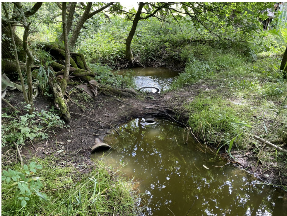
Figur 1 Foto af eksisterende udløbsanlæg. Kilde: Kolding Kommune
