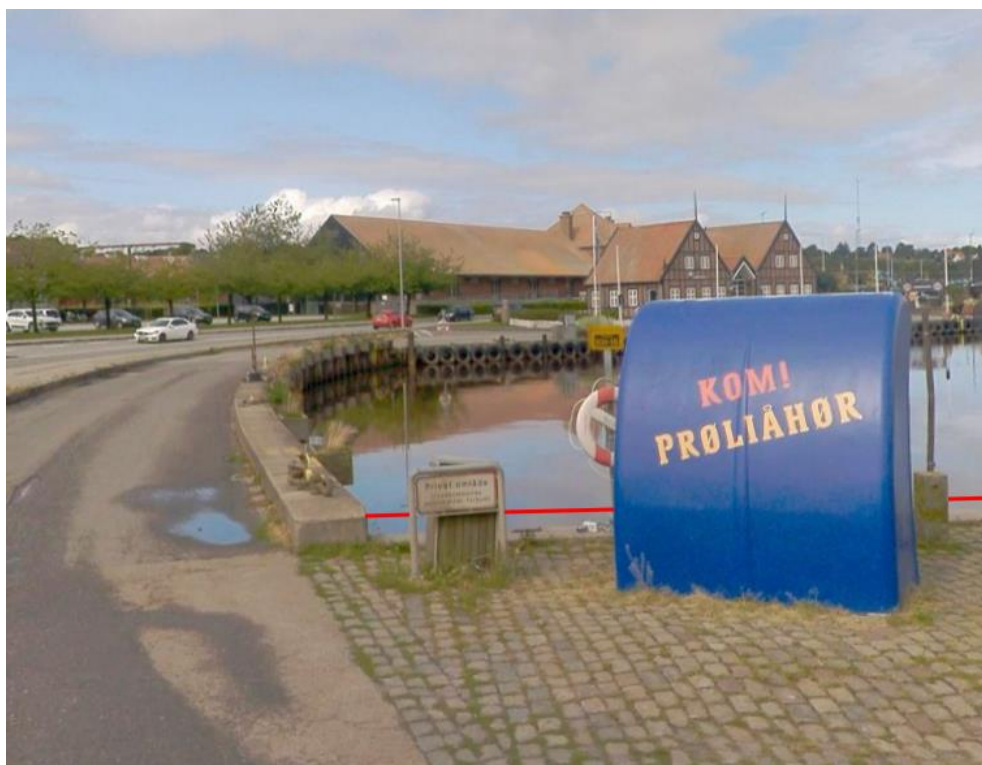
Figur 5: Foto af eksisterende forhold og niveau spring i kajhammeren i knækket ved den sydlige ende af den interne havnevej. Med angivelse af niveau for forhøjet hammer.
