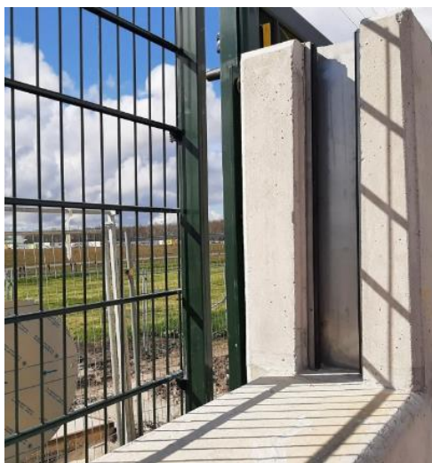
Figur 10: Afslutning med indstøbning af ende skinne.
