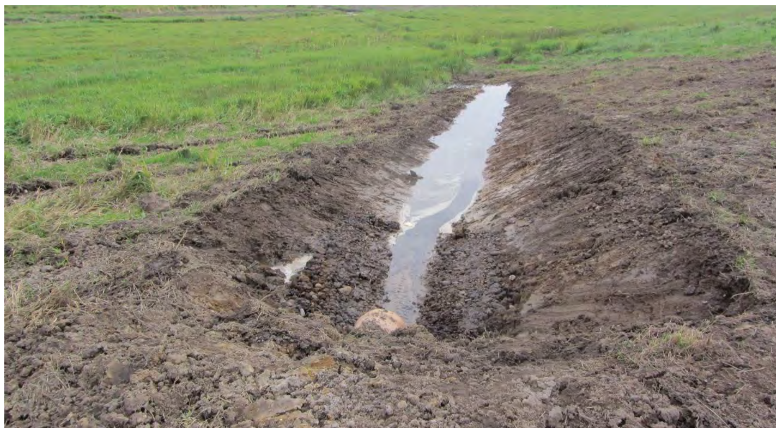
Figur 27 Eksempel på drænudløb i projektgrænsen til ny terrænnær grøft og videre udløb over terræn ved Birkemosen, Kolding.
