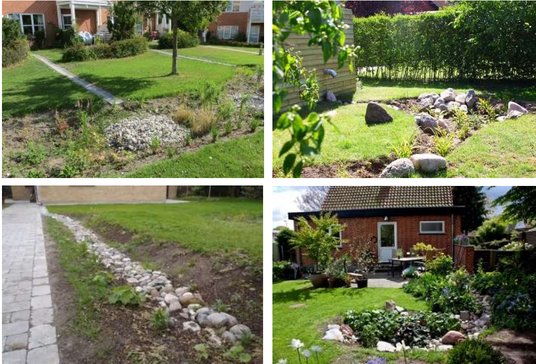
Figur 8-7: Eksempler på regnbede. Kilde: LAR i Danmark
