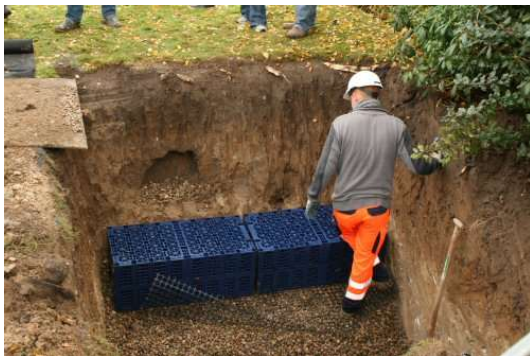
Figur 8-8: Eksempler på nedsivning via faskine. Kilde: LAR i Danmark
