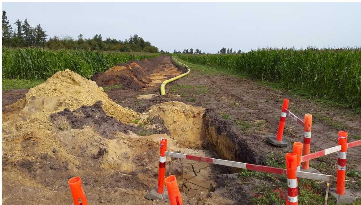
Figur 1: eksempel på anlæggelse af gasledning i rørgrav. Boregrube til underboring ses nederst i billedet.
