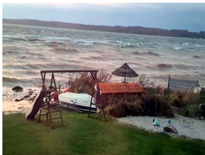
Naboens bro hamrede ind i trappe, mur og skråning
