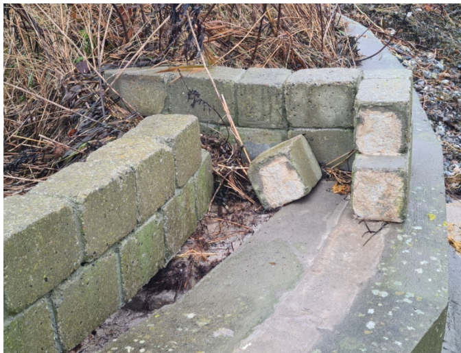
De 2 rækker sten blev slået løse ved mødet med naboen's bro under novemberstormen 2022
