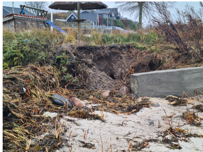
Bepantning, sand og småsten blev revet væk af den løsrevne bro og mur blev betragtelig mere synligt
