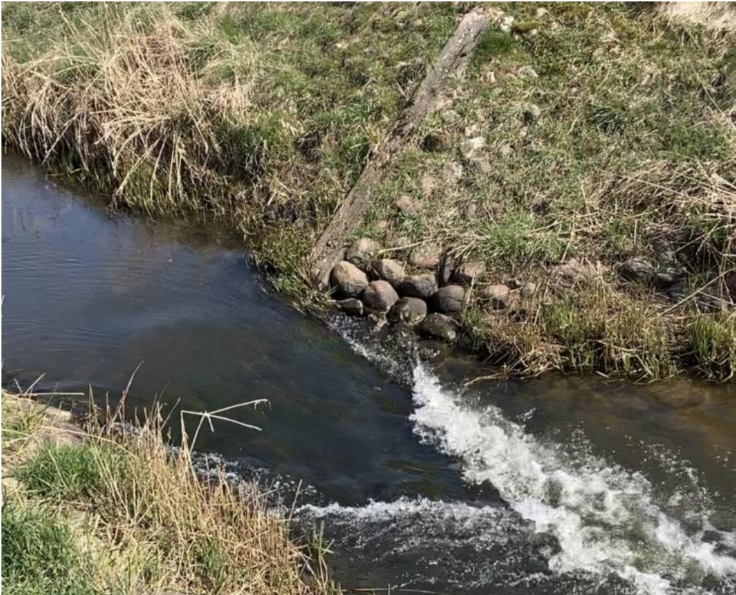
Figur 4. Betonfløje og store sten på skråningsanlægget, maj 2022
