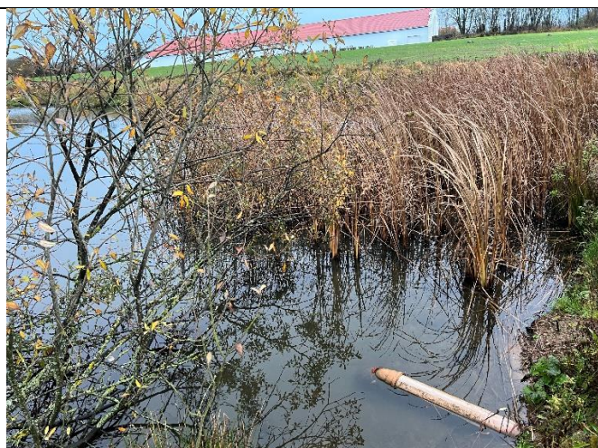
Den nordlige sø udløb i fast rør. Viser sydlige bred.
