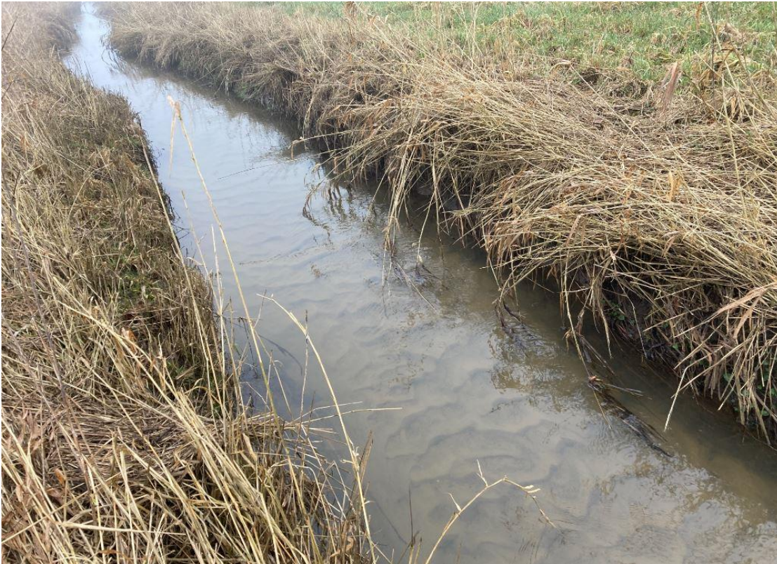
Figur 2. Tydelig sandvandring i st. 2.330
