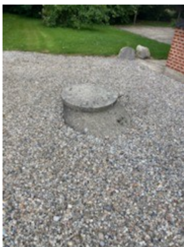
Figur 2 - Indvindingsboring DGU nr. 133.835.
