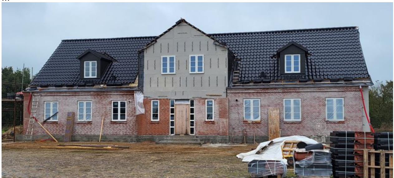
Foto af stuehus under opførelse facade mod syd, jf. ansøgningen
