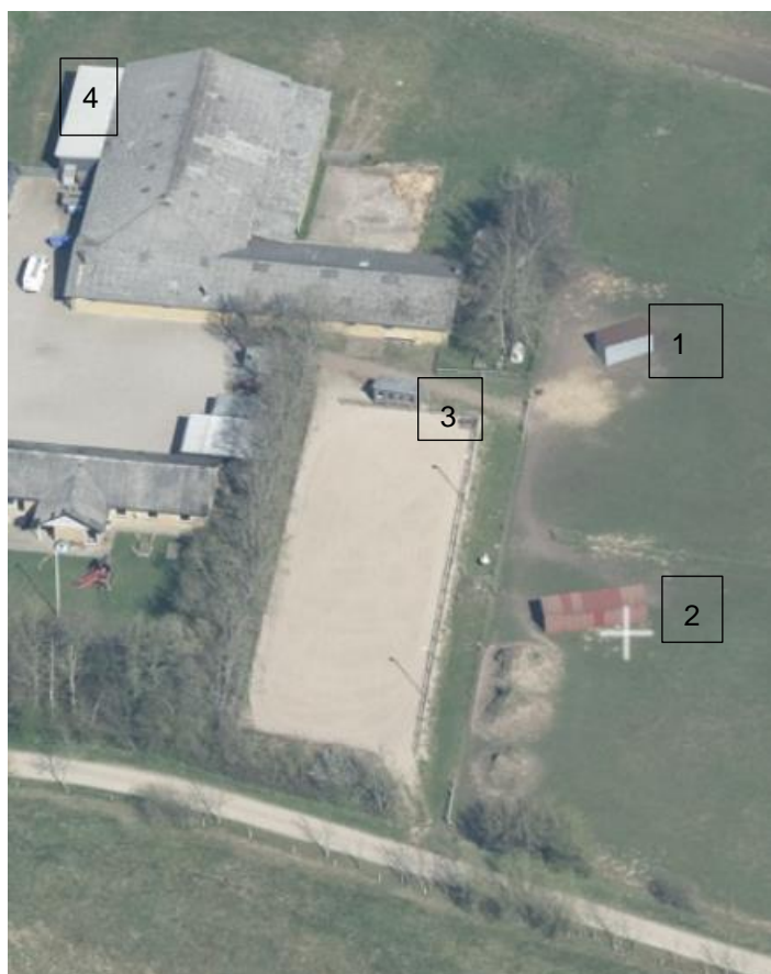
Luffoto forår 2023 med læskurene på marken (1 og 2), mindre udhus nord for ridebanen (3) og udhus med lyst tagbeklædning vest for ladebygningen (4).
