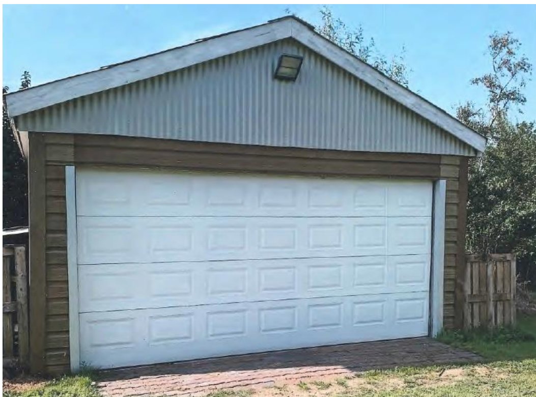
Foto af bygning 5, jf. ansøgningen
