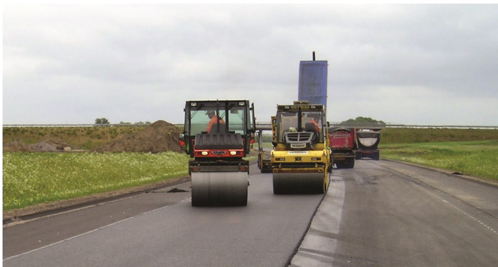
Figur 6.7 Anlægsarbejder på en vejstrækning.
