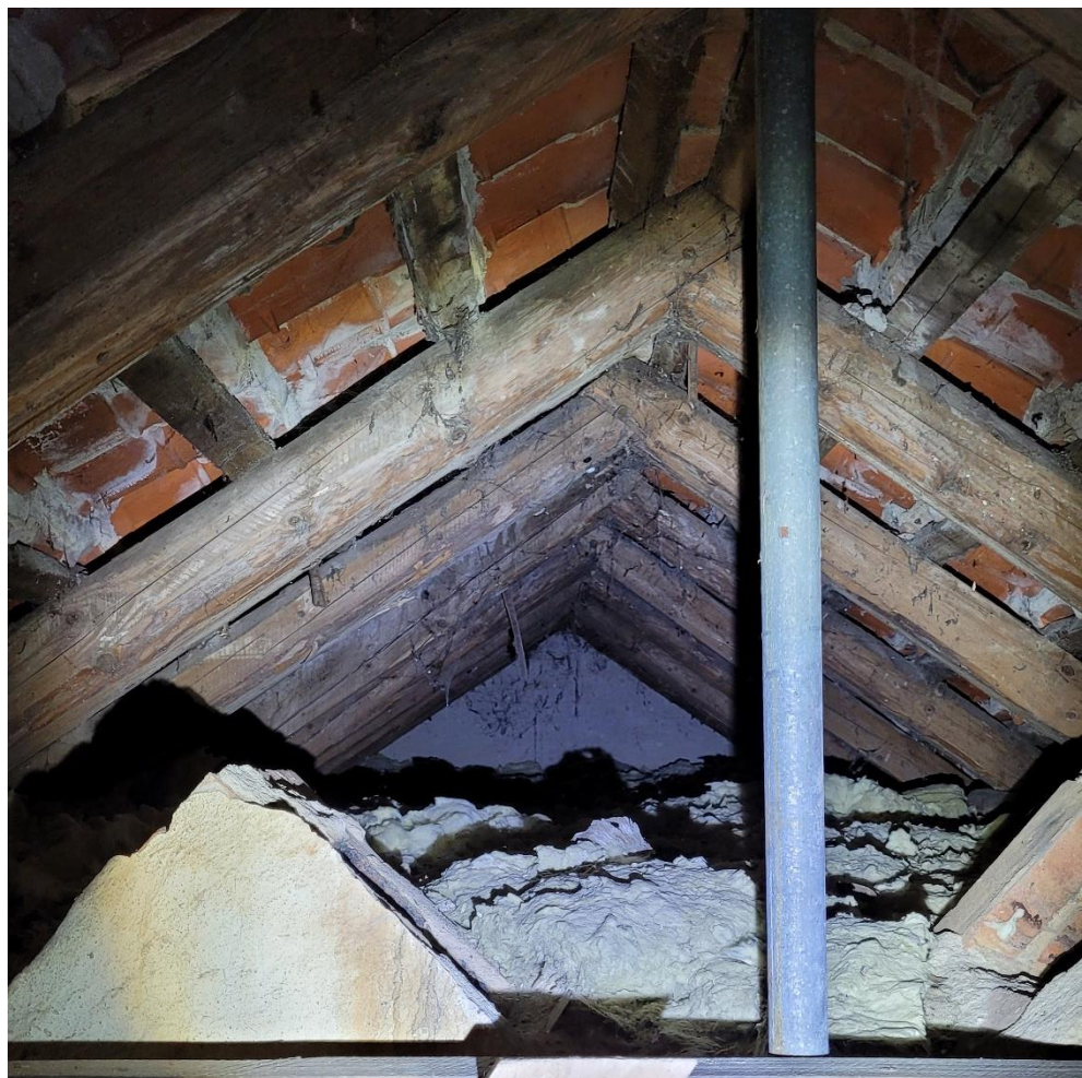
Figur 4-10 Loftet i bygning B3.
