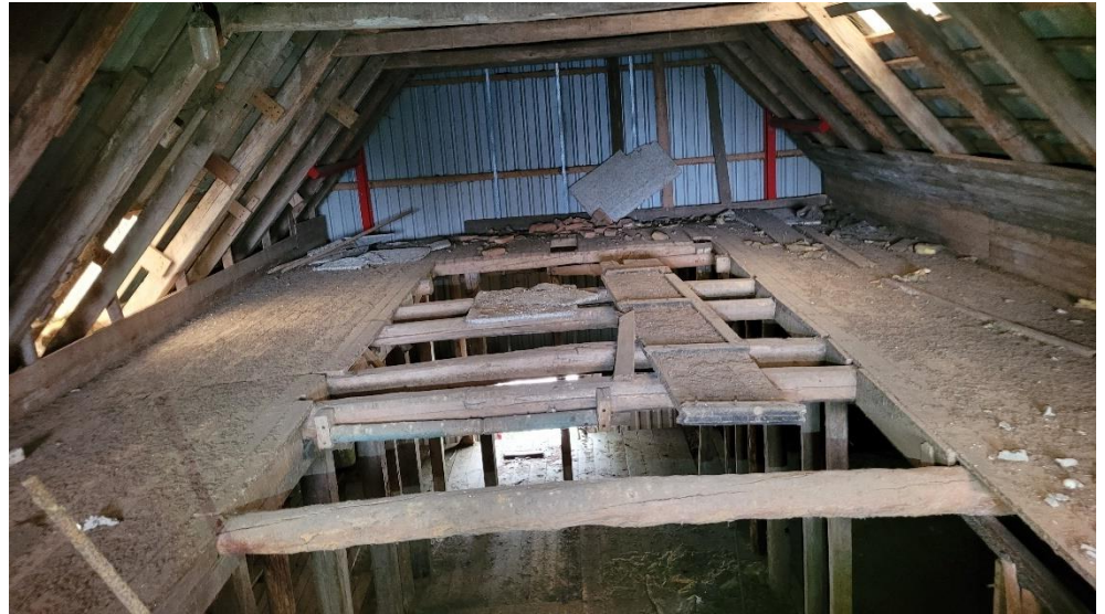
Figur 4-8 Øverste del af loft i bygning B2. Nedenunder ses nederste del af loftet.
