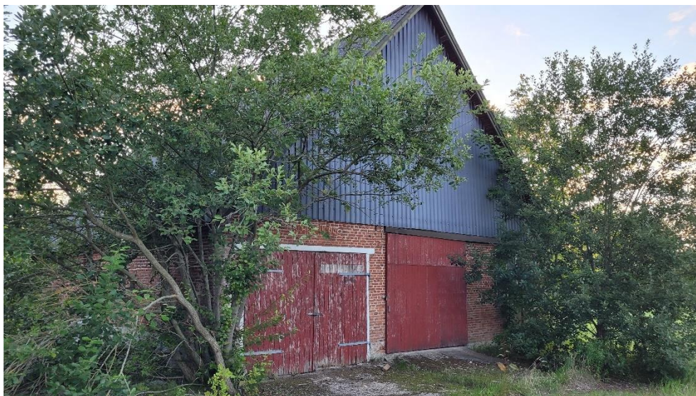
Figur 4-3 Østlige gavl af bygning B1.
