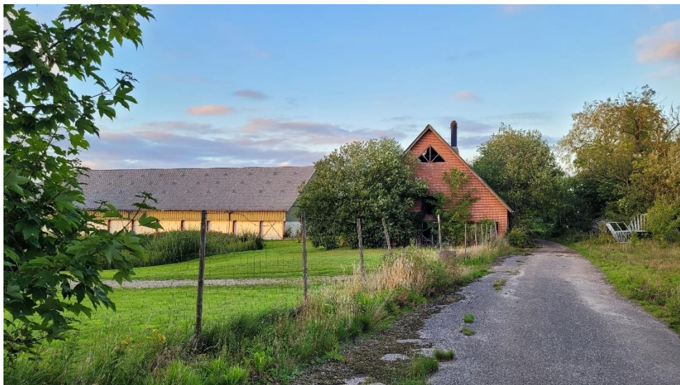
Figur 4-6 Den vestlige gavl af bygning B2 (røde mursten). I baggrunden i venstre side ses siden af bygning B8 (gule plader).
