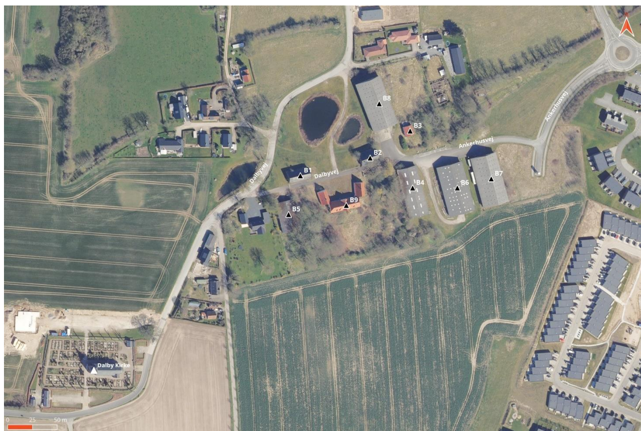
Figur 1-1 De undersøgte bygninger (B1-B8) på Dalbyvej 86 og 85a samt på Ankerhusvej 1-5. Bygning B9 er ikke undersøgt, da den ikke er i risiko for nedrivning.
