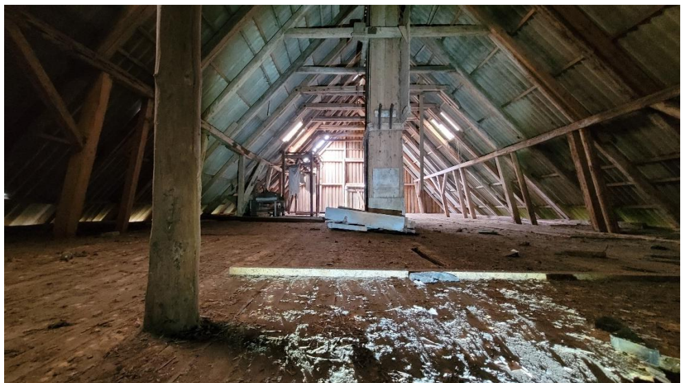
Figur 4-5 Loftrum i bygning B1.
