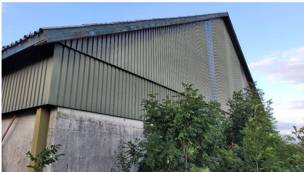
Figur 4-16 Bygningernes gavle er lavet i stålblader.
