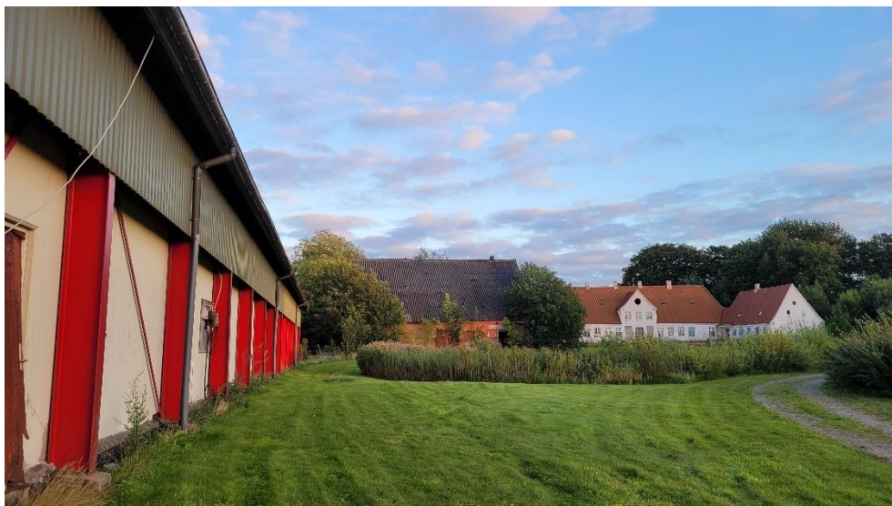
Figur 4-20 Den vestlige side af bygning B8. Baggrunden ses bygning B2 og bygning B9.
