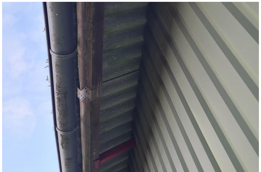
Figur 4-15 Tagpladerne ses under tagudhænget og op til tagpladerne er der sat stålplader. Bygningens konstruktion gør den uegnet som yngle- eller rastested for flagermus.
