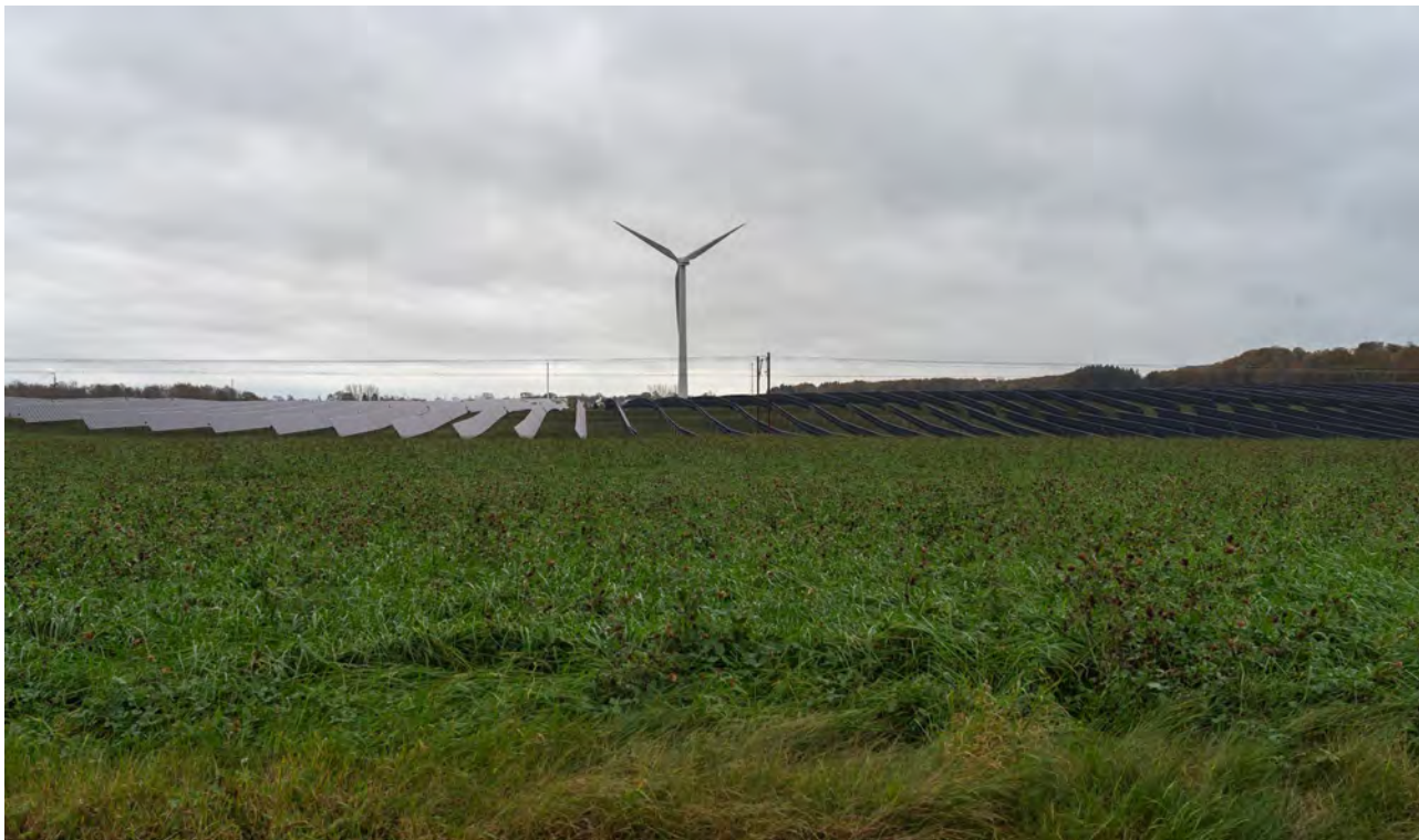
Figur 7-55 Fotopunkt 9 – Visualisering af anlægget uden beplantning. Størstedelen af anlægget vil være synligt umiddelbart efter etablering.
