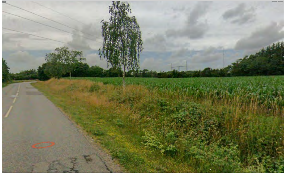
Figur 7-8 Kig fra Nagbølvej mod transformerstation, højspændingsledninger og telemast. Kilde: COWI Gadefoto 2020.
