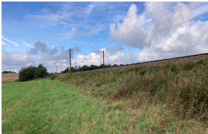
Figur 4-46 NA22J. Banedæmningen er høj i områdets vestlige ende, med tæt vegetation. Foto taget i retning mod vest.
