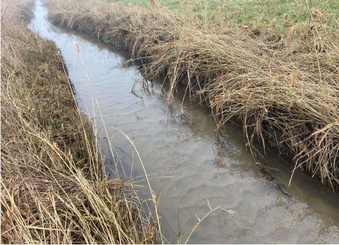
Figur 2. Tydelig sandvandring i st. 2.330
