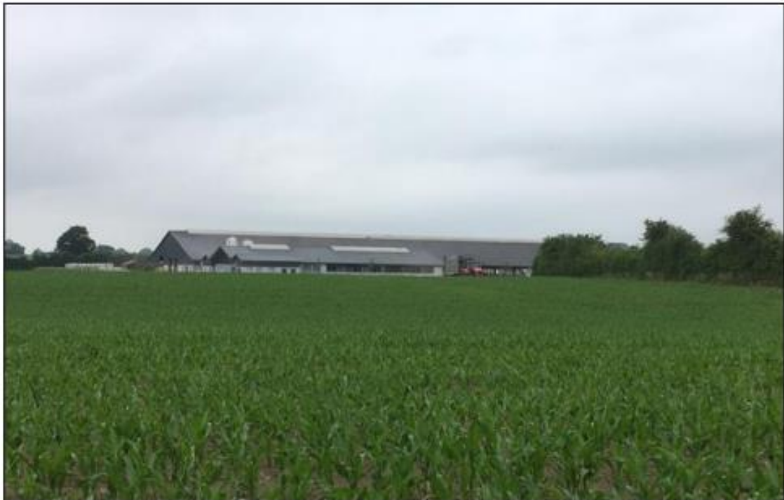
Figur 4 Ejendommen set fra sydøst. Man ser ind imod malkestalden.
