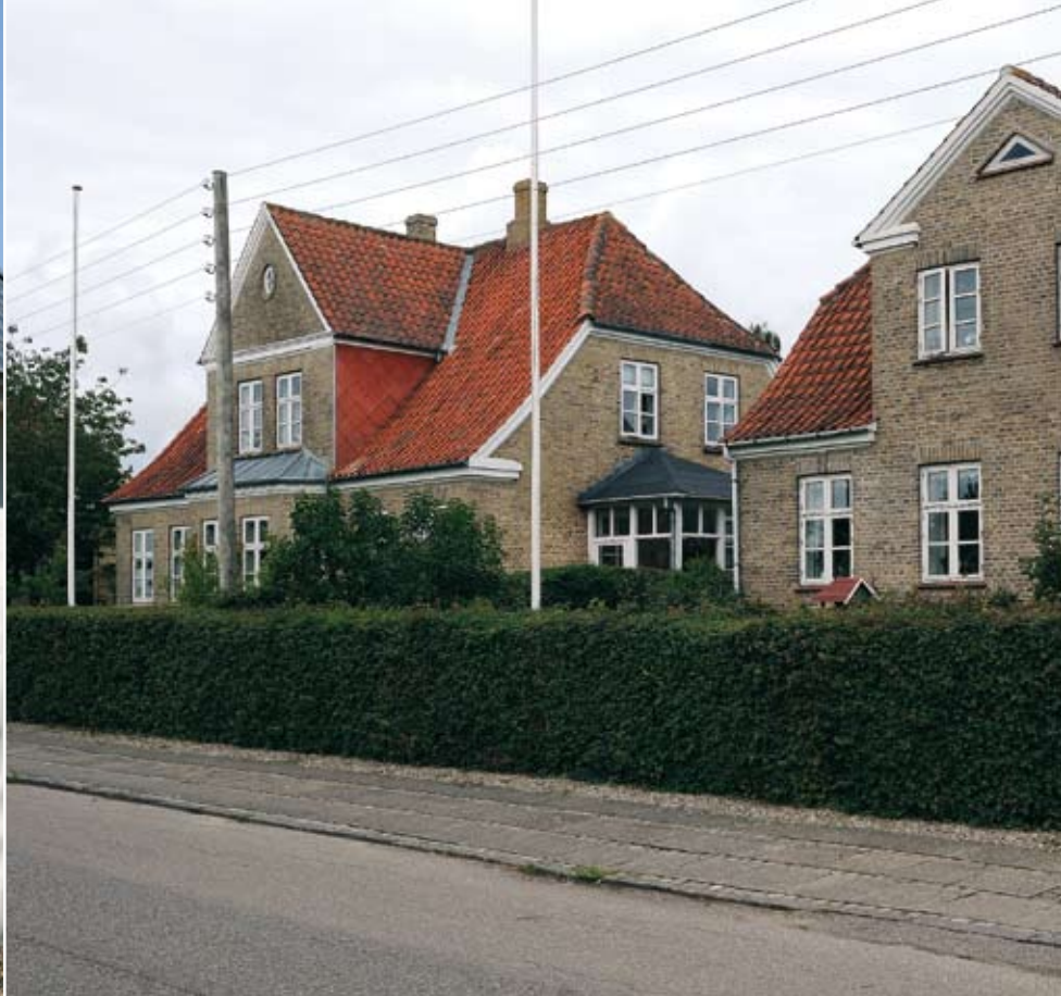
Klassiske facader på villaer, Christiansfeld. Husene er restaurerede med nye, småsprossede vinduer af træ. De originale tagbelægninger er bevarede i respekt for husenes oprindelige arkitektur.
