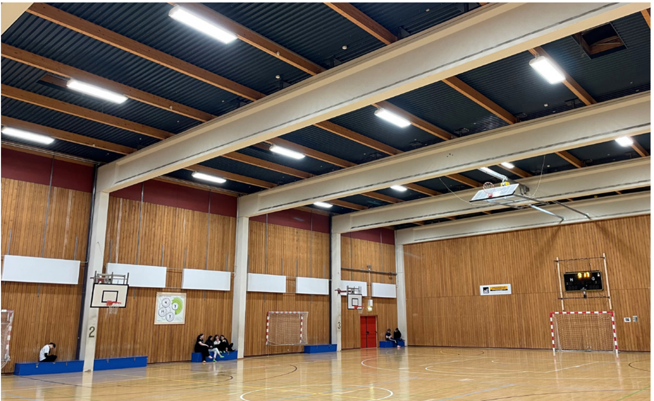
Munkevængets hal. Fra energisluggende ventilationsanlæg til radiatorvarme.
