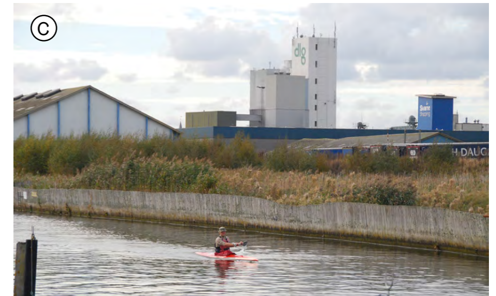
Kolding Havn set fra Marina Syd. Erhvervshavnens bygninger varierer meget i højde og udtryk.
