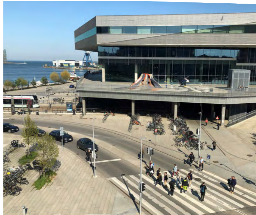
Havnegade i Aarhus blev i forbindelse med anlæggelsen af Aarhus Havnefront indsnævret fra 4 til 2 gennemgående kørebaneer for at nedbryde barrierenvirkningen af trafikken.
