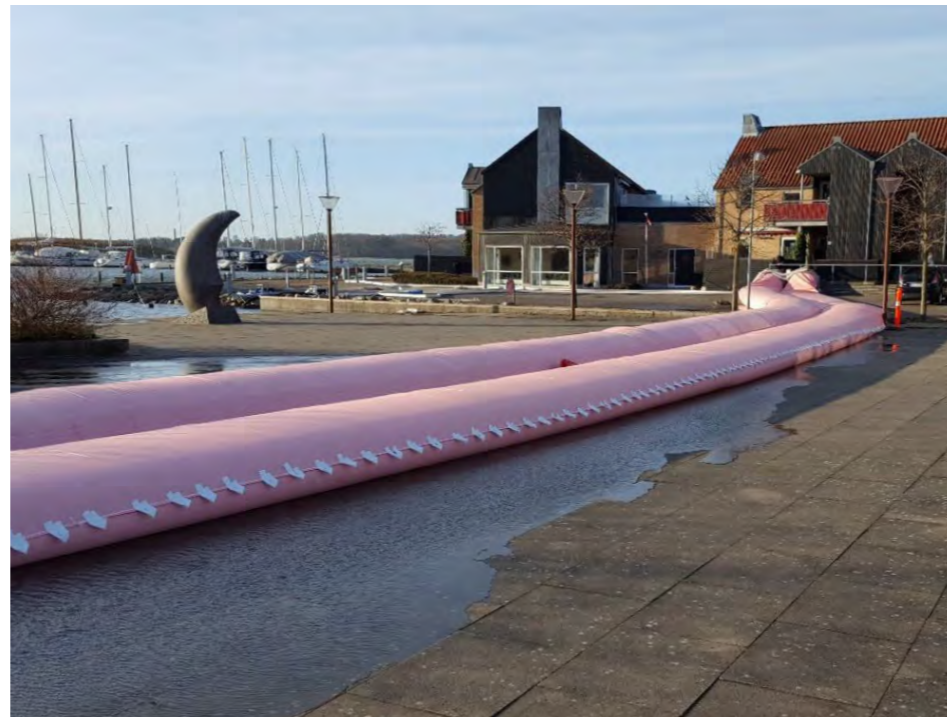
Ovenfor ses et eksempel på en water-tube som er en midlertidig løsning man bruger når der er behov for ekstra klimasikring.
