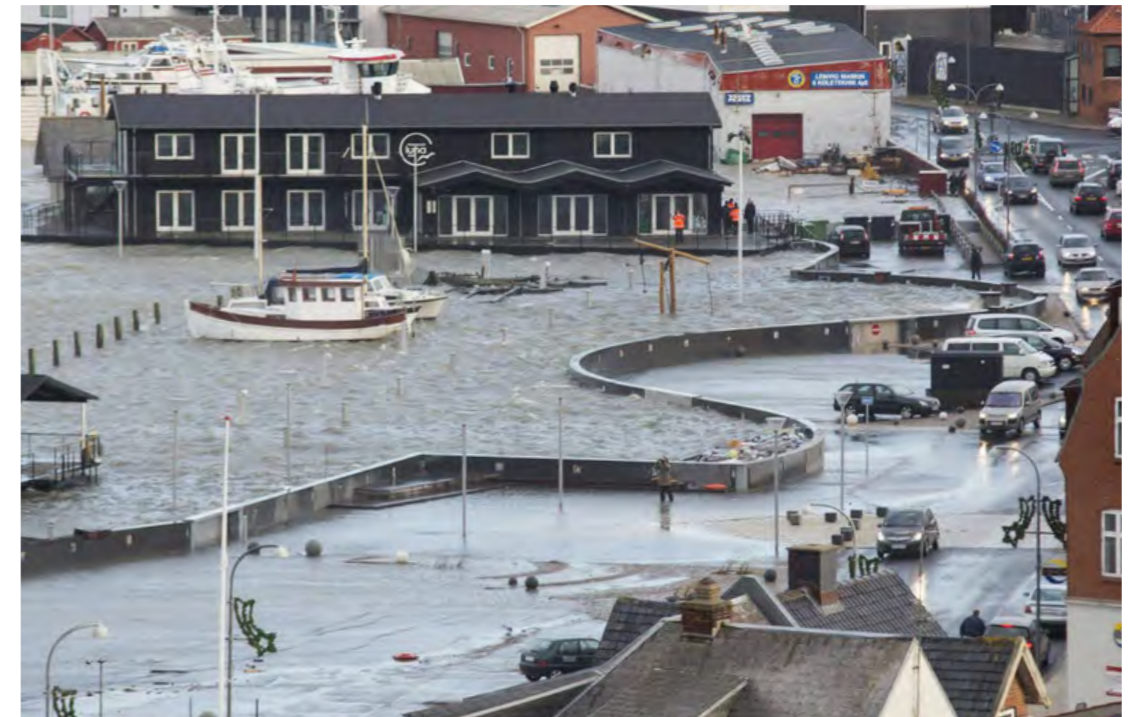
Der er etableret en højvandsmur på havnen i Lemvig. Ved normal vandstand, bruges elementet til ophold og adskillelse mellem arealer til kørsel og arealer uden kørsel.
