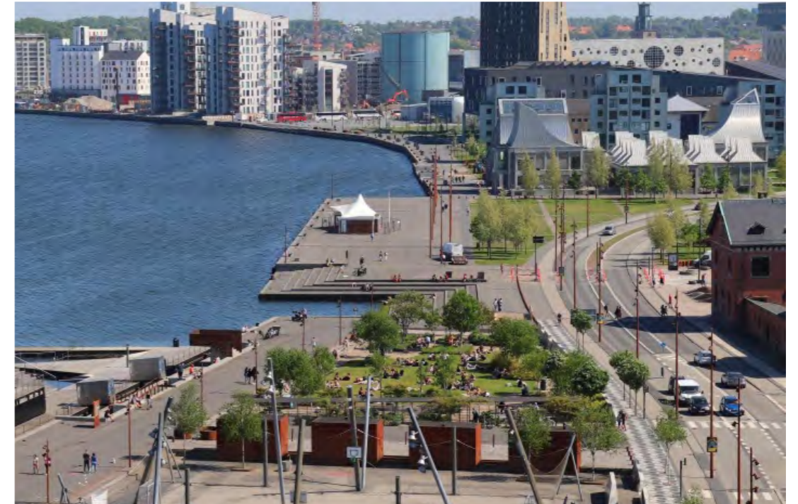
Strandvejen i Aalborg blev i forbindelse med anlæggelsen af Aalborg Havnefront indsnævret fra 4 til 2 gennemgående kørebaneer for at nedbryde barrierenvirkningen af trafikken.
